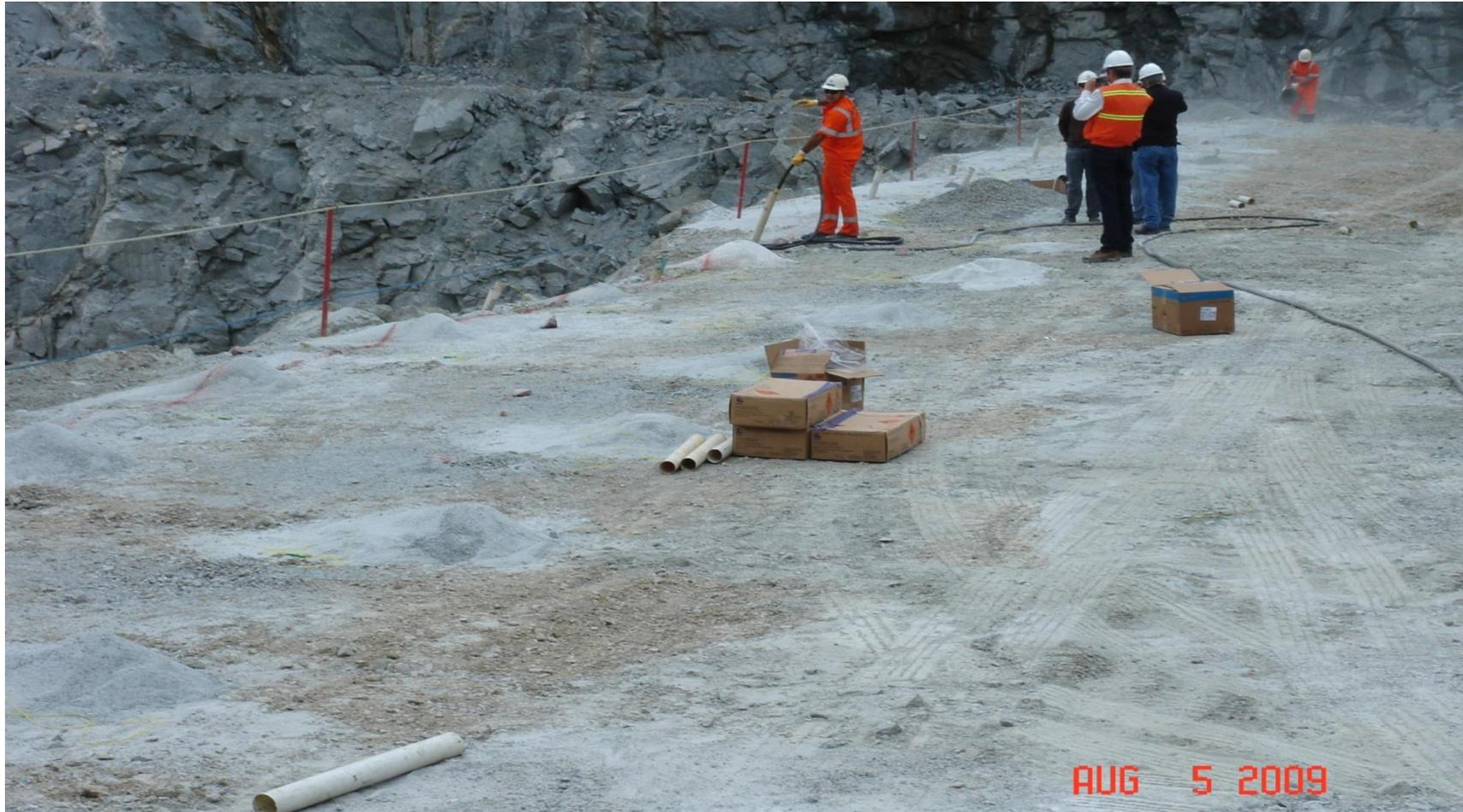
Banco del frente de cantera donde se muestra al operador cargando, con la emulsión de Centra Gold, los barrenos con una manguera que sirve para llevar por bombeo el producto desde la pipa mezcladora hasta el barreno. También se observan los mochos de tubos plásticos utilizados como boquillas de los barrenos y las cajas de los boster de Pentex.
