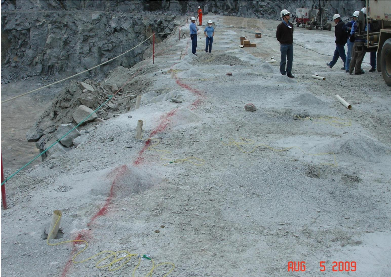
Banco del frente de cantera con los barrenos cargados, el conductor eléctrico con el microrretardo y la boquilla plástica del barreno.
